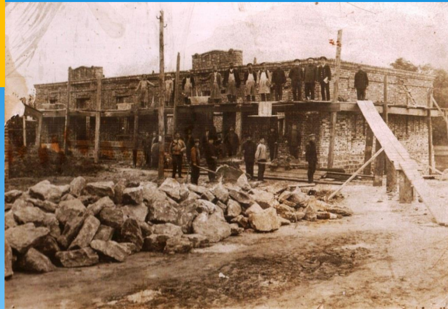
Строительство железнодорожного вокзала ст. Двойная. 30-е годы 20 века
